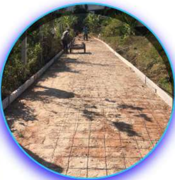
ผู้รับจ้าง ลงดำเนินงานถนนคอนกรีตเสริมเหล็ก หมู่ที่ 6
