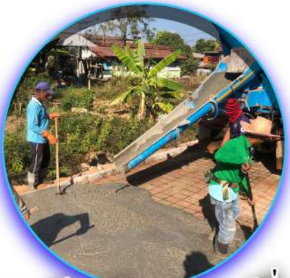
ผู้รับจ้าง ลงดำเนินงานถนนคอนกรีตเสริมเหล็ก หมู่ที่ 6
